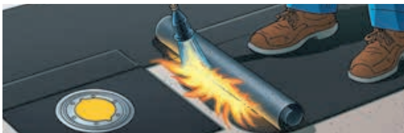
Fig. 322 Svetsa fast bitumen-tätningsbanan med en gasbrännare
