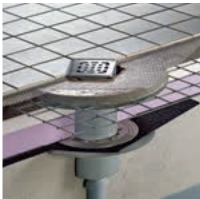
Fig. 330 Påbyggnadselement med stål-galler
