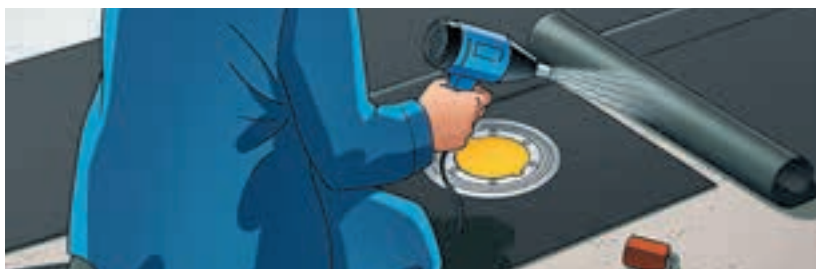
Fig. 323 Svetsa fast EPDM-tätningsbanan med varmluft
